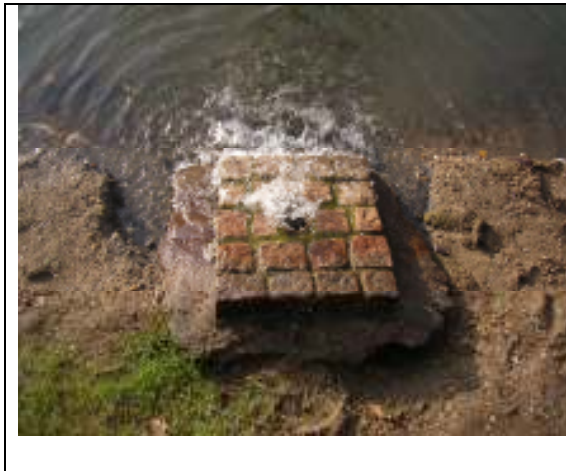
Abb. 2.24: Wassereinspeisung an Gewässer A (September 2006)
