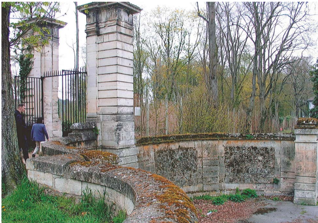
223. Maisons, Eingang der Hauptachse, Portal mit vorgelagerter Mauer, Blick von Rückseite
