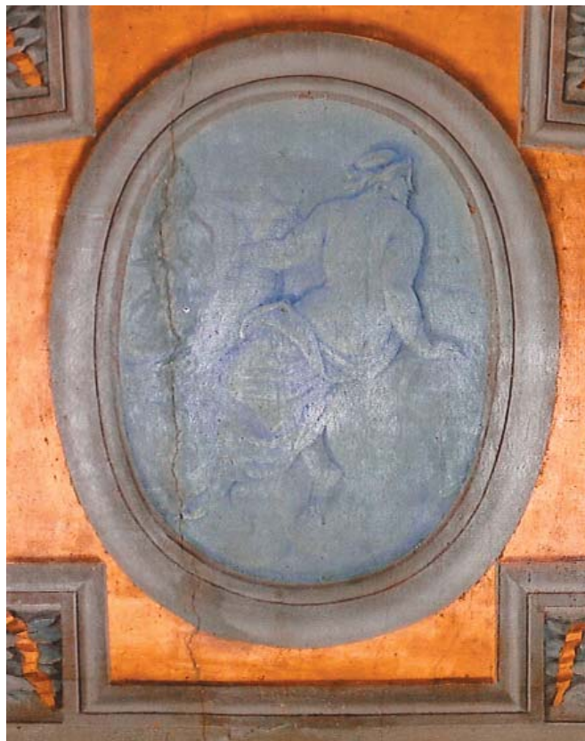
135. Schloss Maisons, salle im appartement du roi, Fensternische Juno
