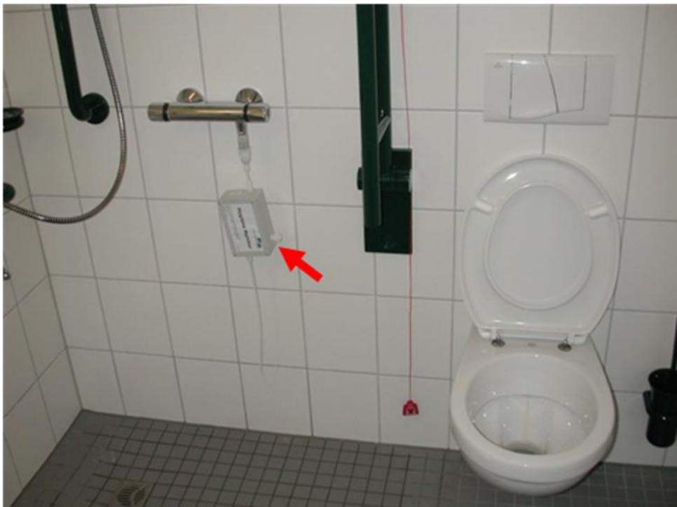
Abb. 36 Hygiene-Monitor mit sterilem Silikonschlauch am Systemende.
