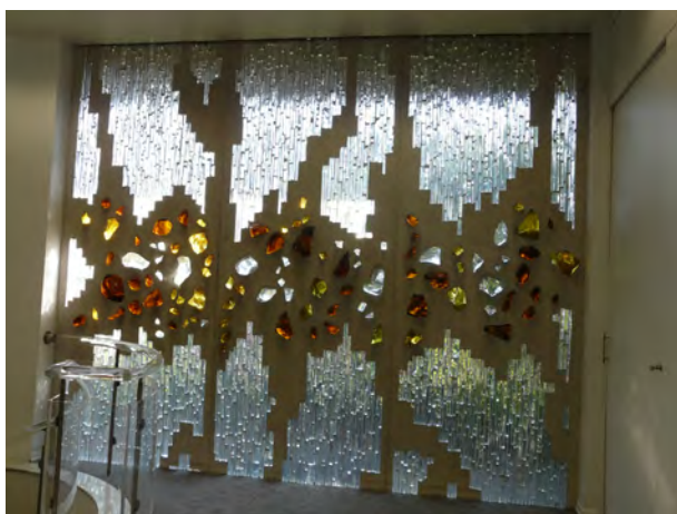
154.1 Betonglaswand in der Schalterhalle (40.1.2)
