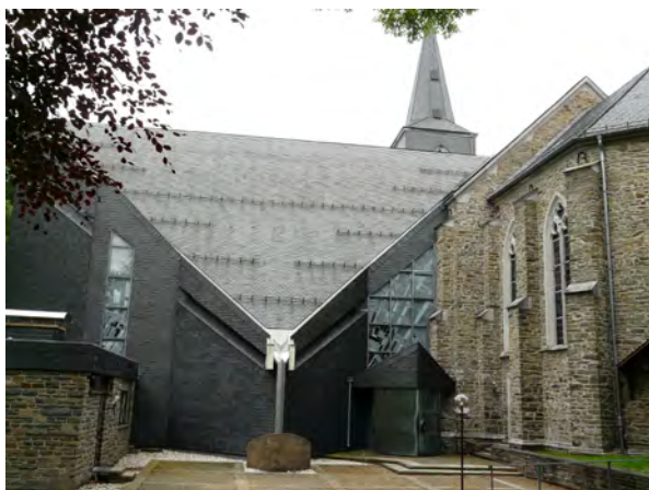
116.1 Außenansicht der Kirche: Alt- und Neubau (58.8.2)
