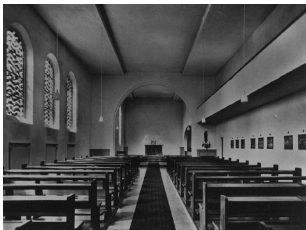
14.3 Ansicht der Kapelle vor dem Umbau 1996 (Foto: Gymnasium St. Ursula)
