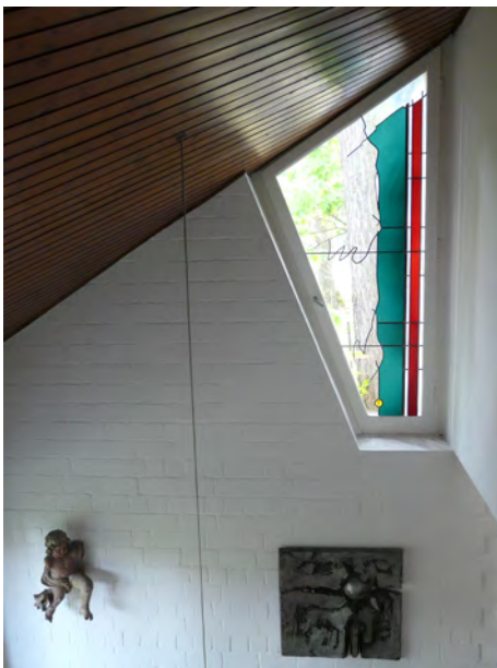
114.1 Fenster im Wohnzimmer (1.3.36)
