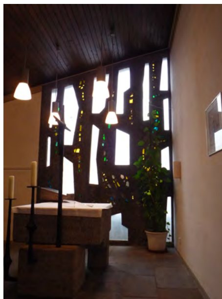
Abb. 229: WK120 Bremen-Hastedt, St. Elisabeth, Fensterdetail aus der rechten Kirchenwand, Betonglas, 1972 (32.2.16)
