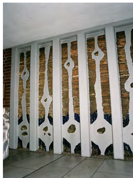
Abb. 457: WK129 Gelsenkirchen-Scholven, St. Josef, Fenster oben in der Kirchenwand, Betonglas, 1973 (16.3.7)
