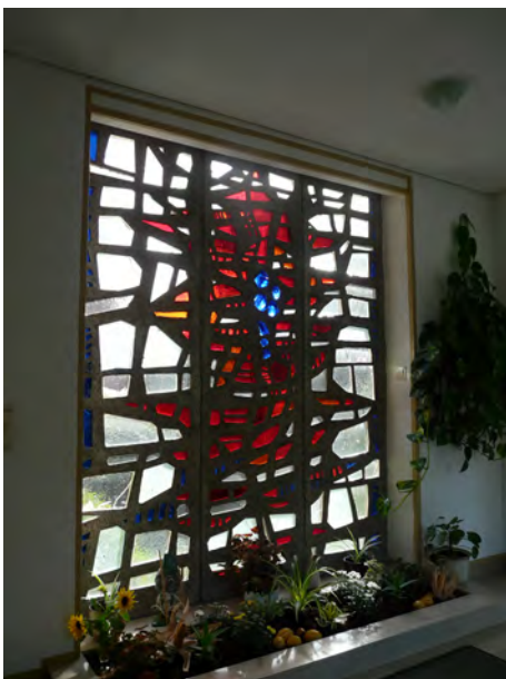
130.5 Betonglasfenster im Eingangsbereich des Klosters (48.6.28)
