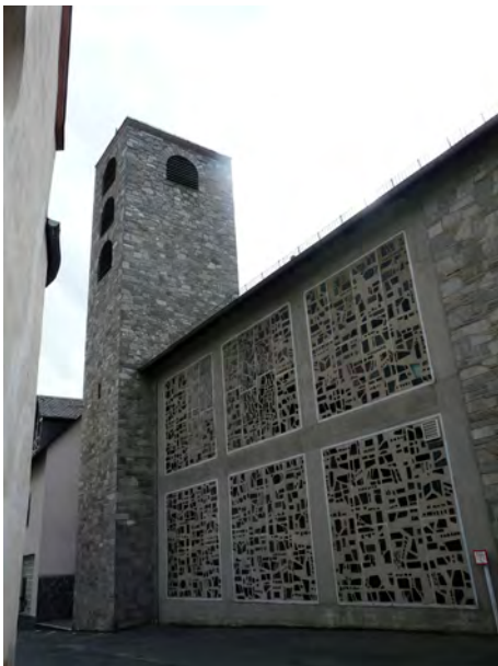
71.1 Rückwärtige Wand der Kirche mit der Betonverglasung (55.2.21)
