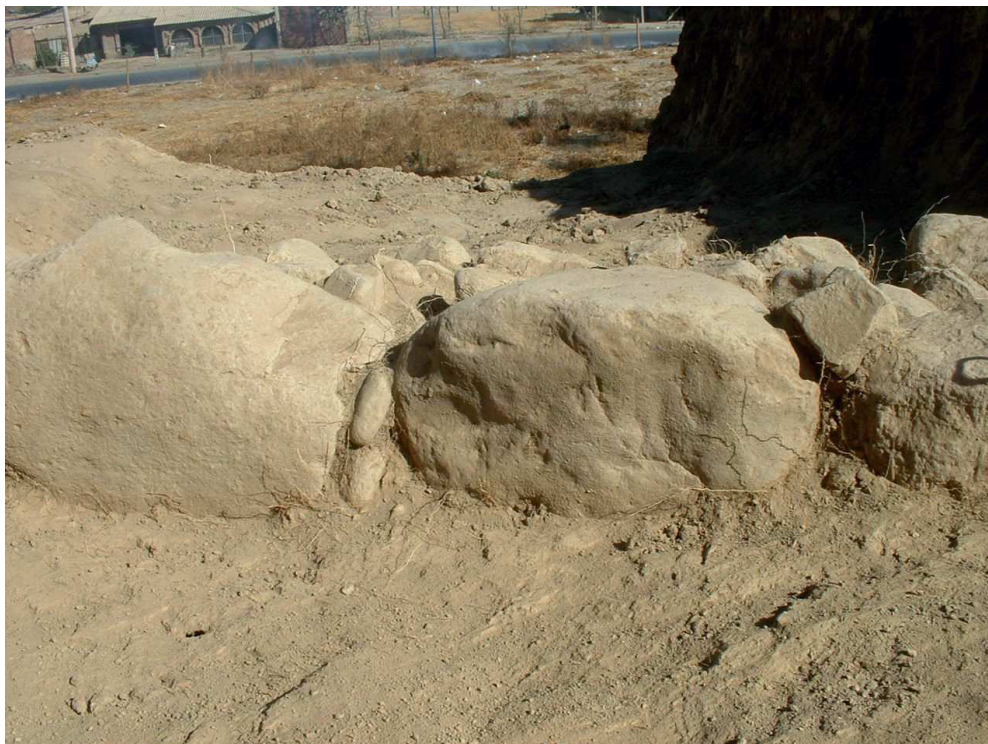
Abb.10.26: Detail von M-4, Lücken zwischen große Steinblöcke werden mit kleineren Flusststeinen aufgefüllt
