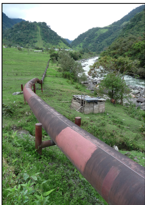
Abb. 30: Transecuadorianische Ölpipeline (SOTE)
