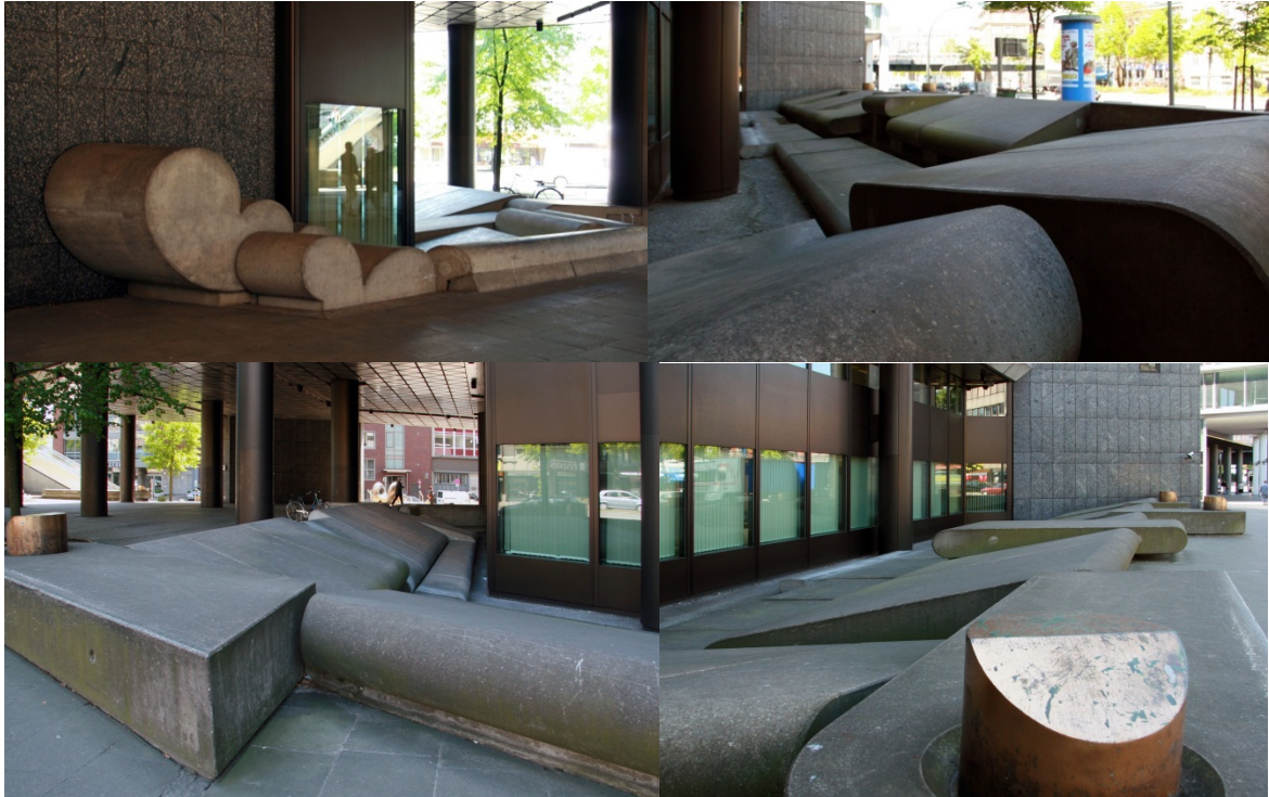
Abb. 135: Betonrelief mit Lüftungsöffnungen
