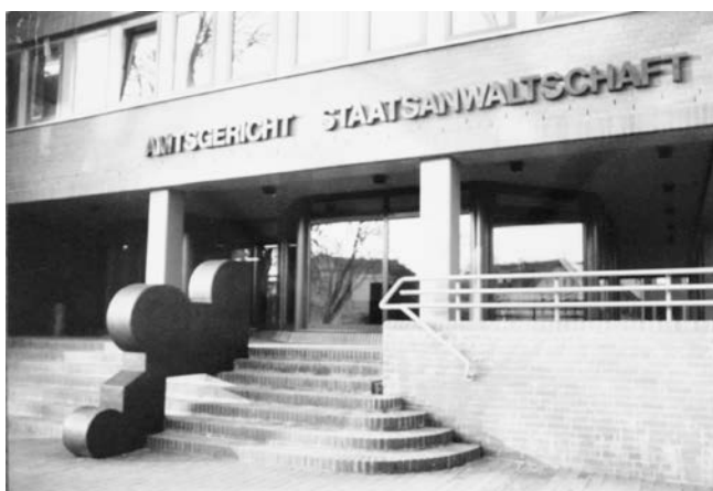
Abb. 147 a: „Treppenreiter“ ursprüngliche Situation
