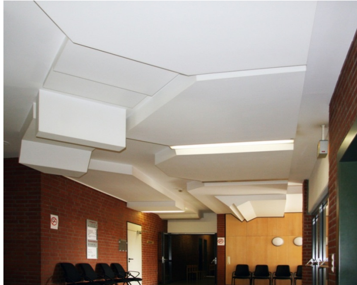
Abb. 145: Deckenrelief mit integrierter Beleuchtung
