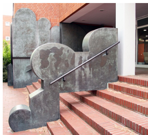
Abb. 147 b: „Treppenreiter“ (versetzt) mit Handlauf
