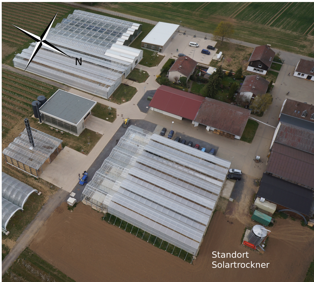
Abbildung 4.2.: Standort des Solartrockners am Campus Klein-Altendorf Nord; [KRASKA, 2016]
