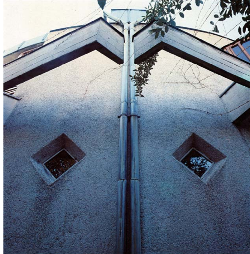
Abb. 173 Villa Veritti, Detail der Nordfassade mit Küchenfenstern
