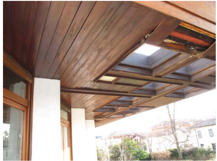
Abb. 86 Villa Romanelli, Dach
