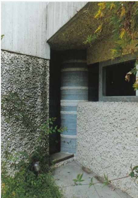
Abb. 361 Villa Ottolenghi, Detail der Westfassade
