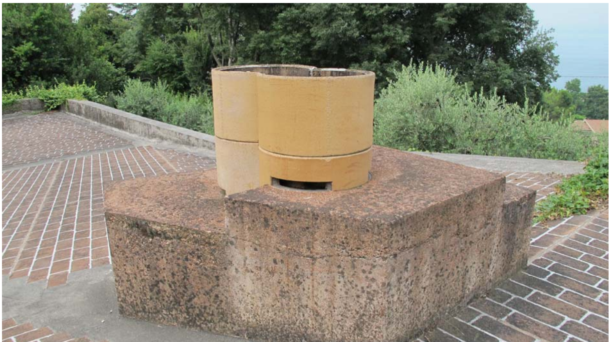
Abb. 341 Villa Ottolenghi, Dachterrasse, Schornstein
