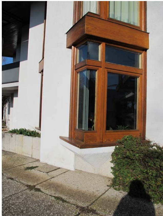
Abb. 84 Villa Romanelli, Detail der Fensterlösung an der Südwestfassade mit pyramidaler Konsole
