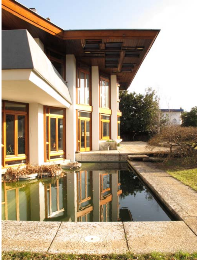
Abb. 90 Villa Romanelli, Blick von Westen auf die Gartenfassade
