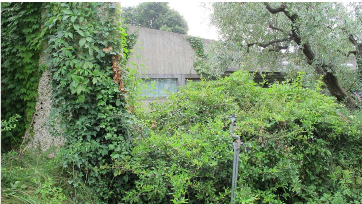
Abb. 359 Villa Ottolenghi, Westfassade
