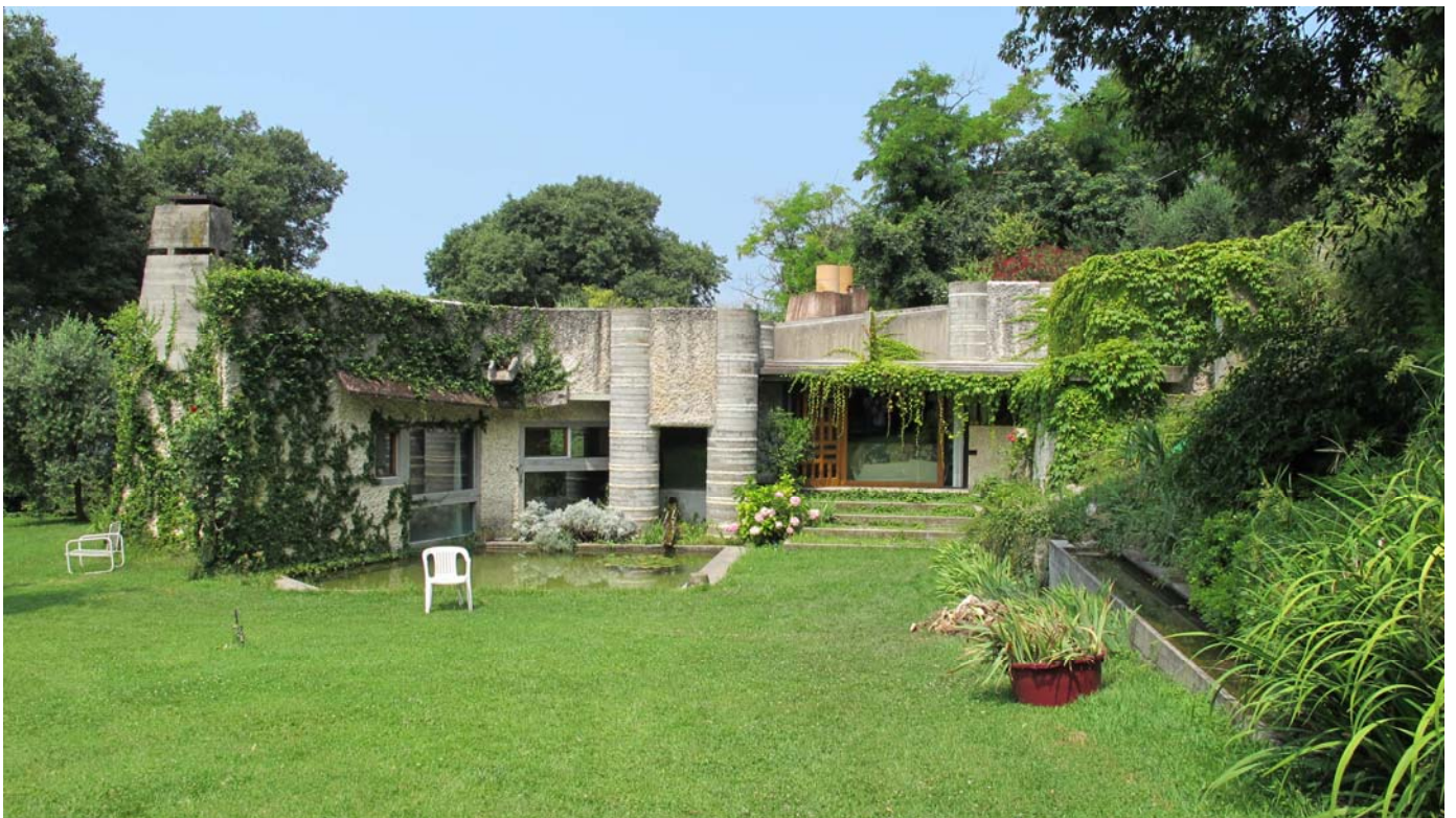
Abb. 352 Villa Ottolenghi, Ostfassade
