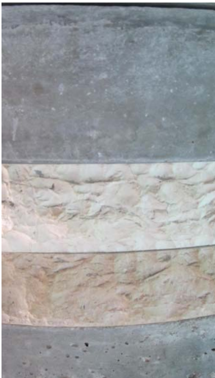
Abb. 372 Villa Ottolenghi, Detail eines Pfeilers
