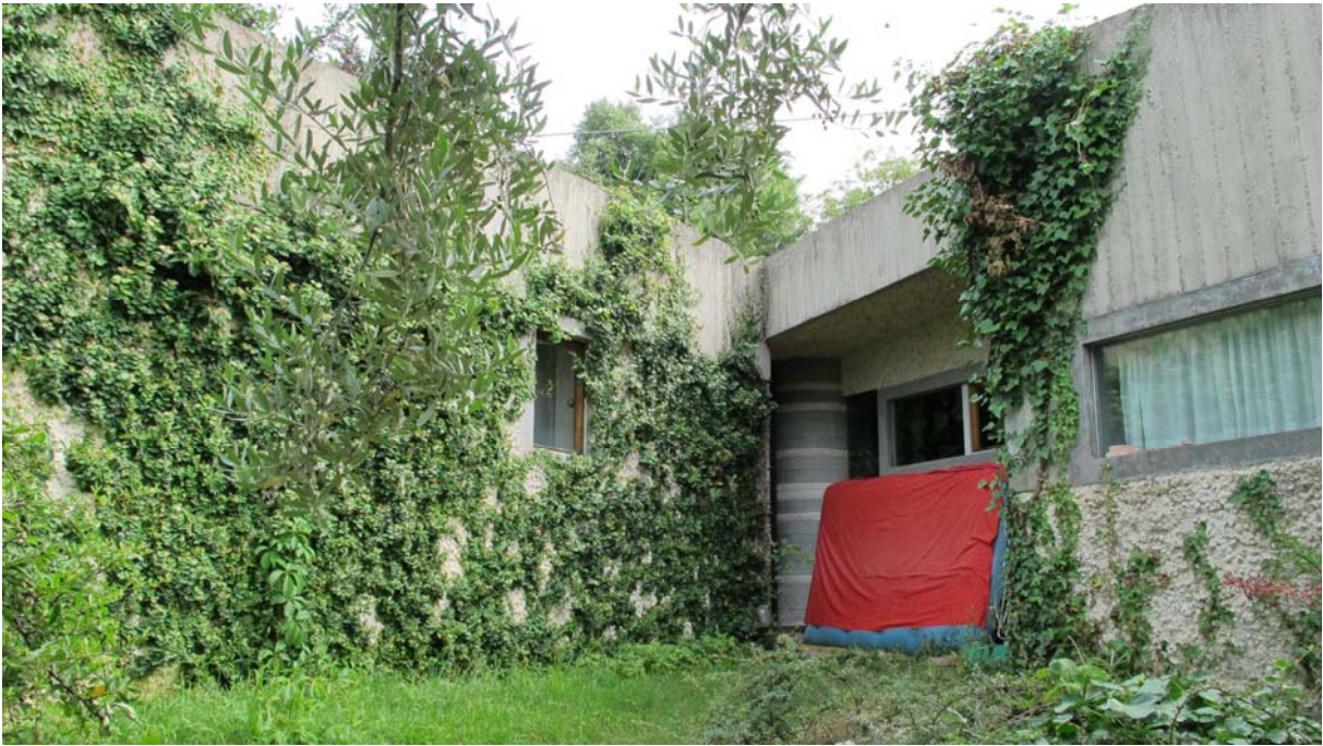
Abb. 360 Villa Ottolenghi, Westfassade
