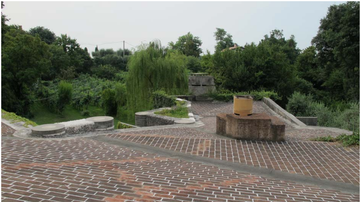
Abb. 339 Villa Ottolenghi, Dachterrasse
