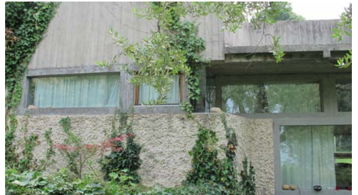
Abb. 362 Villa Ottolenghi, Westfassade
