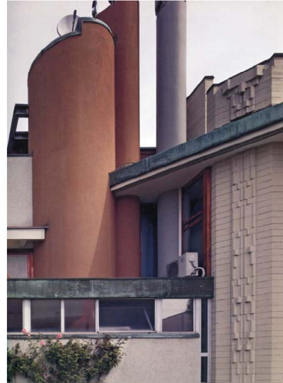
Abb. 168 Villa Veritti, Südwestfassade, Detail des Treppenturms
