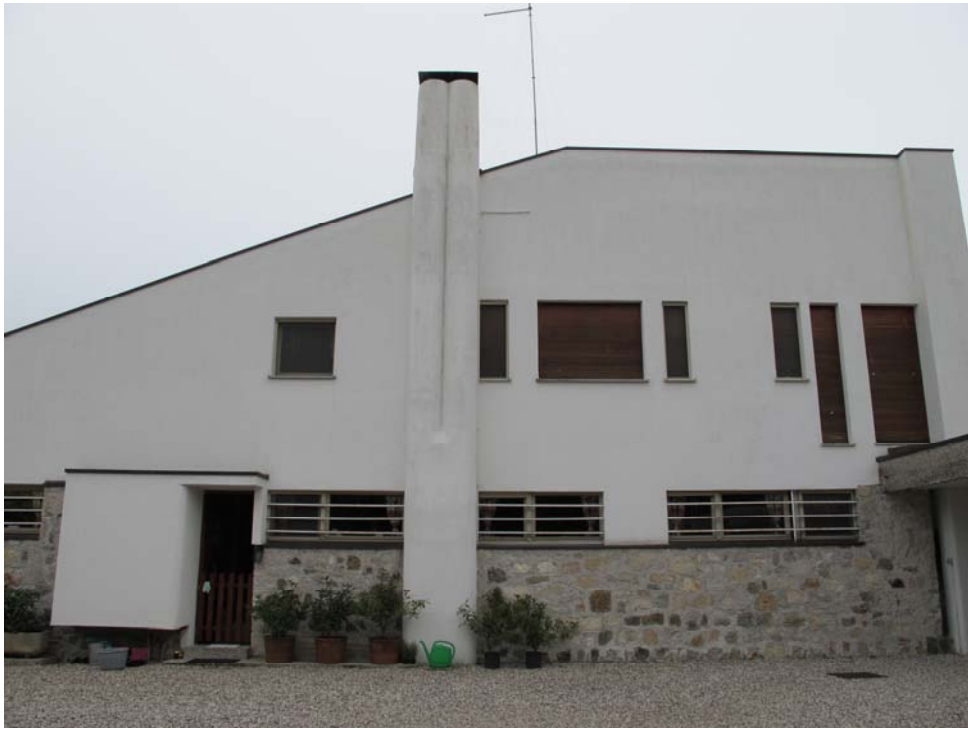
Abb. 44 Villa Bortolotto, Nordfassade im Wirtschaftshof
