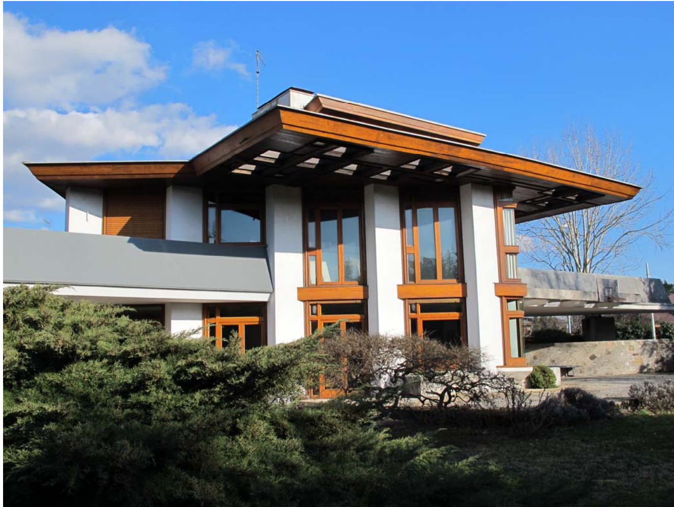
Abb. 92 Villa Romanelli, Blick vom Garten mit Betonbalken auf beiden Seiten
