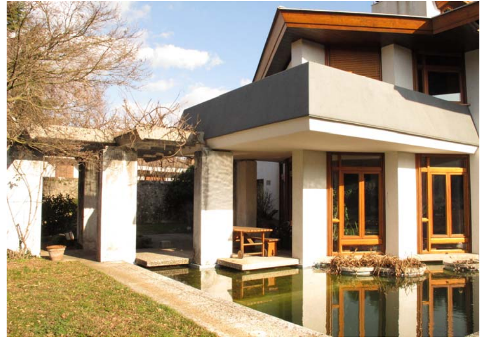
Abb. 95, Villa Romanelli, Blick über das Bassin und die Pergola
