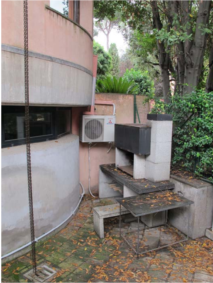
Abb. 278 Casino de Benedetti Bonaiuto, Grill im Norden
