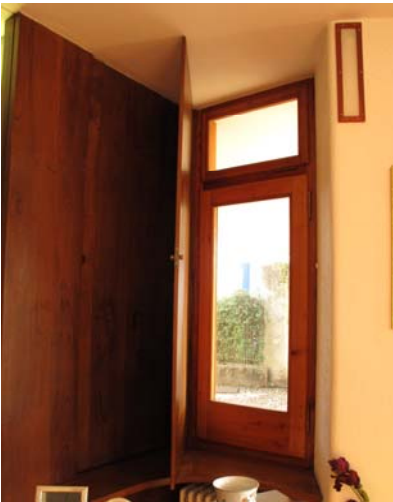
Abb. 98 Villa Romanelli, Detail des östlichen Fensters im Wohnzimmer mit Sichtschutz
