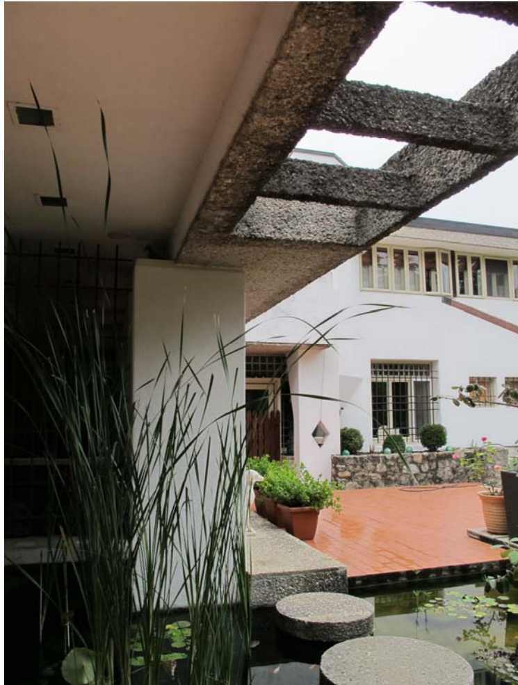
Abb. 51, Villa Bortolotto, Blick von der Gartenloggia auf die nördliche Gartenfassade
