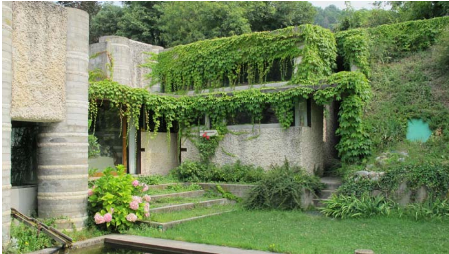
Abb. 354 Villa Ottolenghi, Ostfassade
