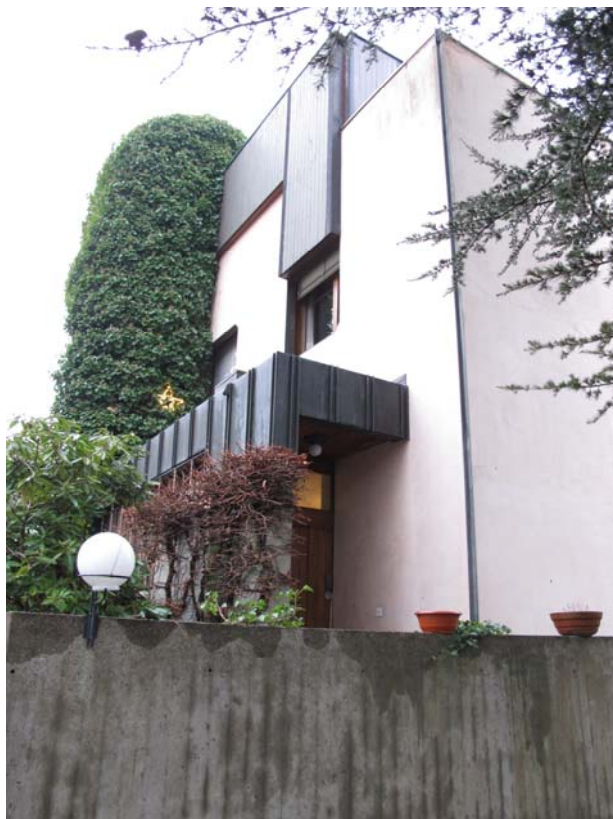
Abb. 239 Villa Zentner, Kucheneingang im Nordosten
