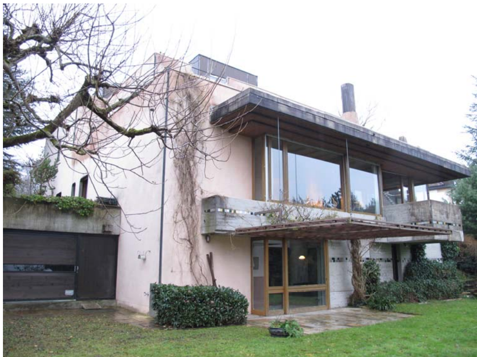
Abb. 241 Villa Zentner Nord- und Westfassade
