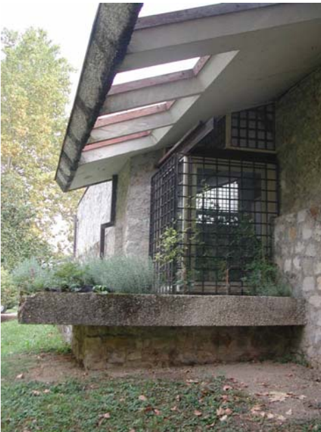
Abb. 43 Villa Bortolotto, Detail der Südostecke mit Glaserker und Pergola-Dach
