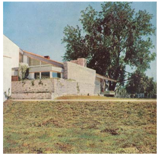
Abb. 42 Villa Bortolotto, alte Ansicht der Nordwestecke mit Wohnzimmer
