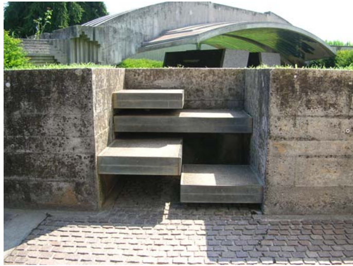
Abb. 402 Carlo Scarpa, San Vito d'Altivole, Brion-Grabmal, ab 1969, Treppe
