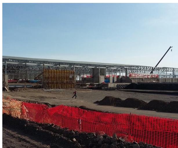
Abb. 163: Baustelle des neuen Cargo Terminals am Addis Ababa Airport (Foto FG, 16.3.2016)
