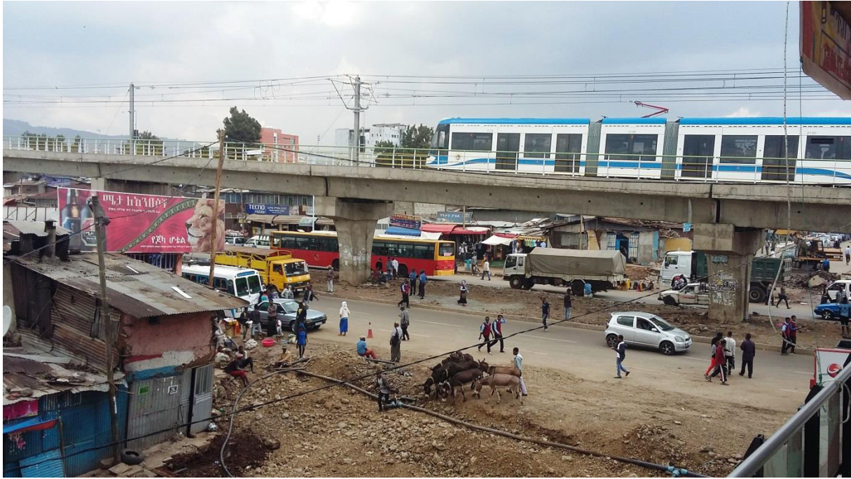
Abb. 134: Neue Stadtbahntrasse in Addis, Nähe Merkato (Foto FG, 7.3.2016)
