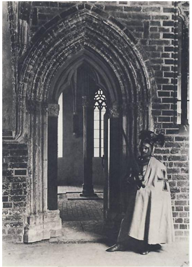
Abb. 4 Eingangstür vom Kreuzgang in den Kapitelsaal Fotografie der Marienburger Schlossbau-Verwaltung von den Wiederherstellungsarbeiten an der Burg, Fotoband 1882-1895 Aus: Hartmut Boockmann, Die Marienburg im 19. Jahrhundert, Frankfurt am Main 1982, Abb. 47
