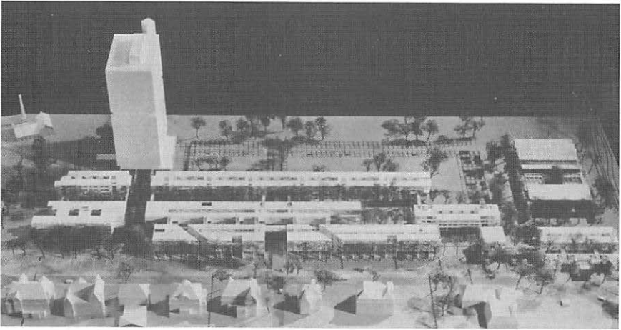
Abb. 16: 1984 - Wettbewerb für ein neues Abgeordnetengebäude (1. Preis: Prof. J. SCHÜRMANN). Seit dem Dezemberhochwasser 1993 liegt der „Schürmannbau“ als Bauruine still. Die Stilllegungskosten haben sich seitdem auf schätzungsweise 25 Mio. DM aussummiert.
