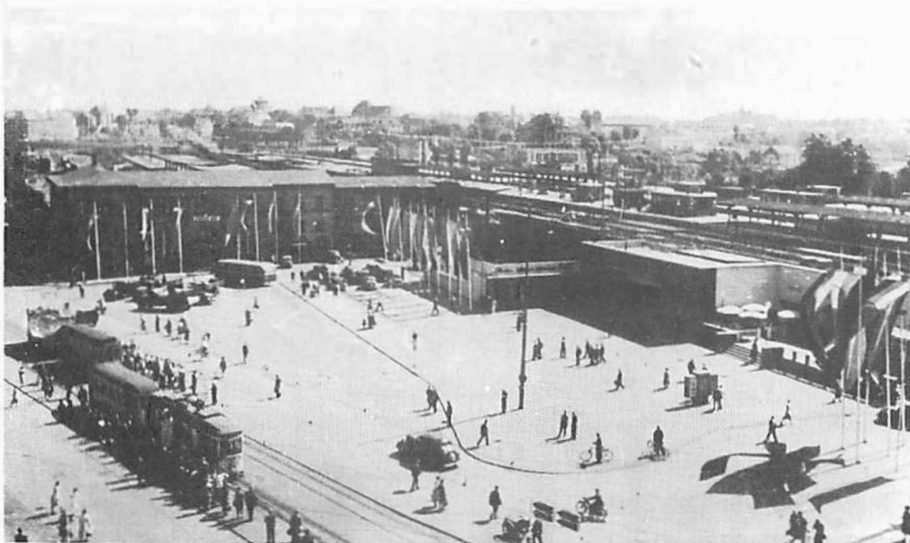
Bild 12: Blick wie bei den vorhergehenden Bildern. Zustand nach der vorläufigen Instandsetzung (Bild vom 24.8.50) vor Beginn des Bahnhofs-Neubaues.
