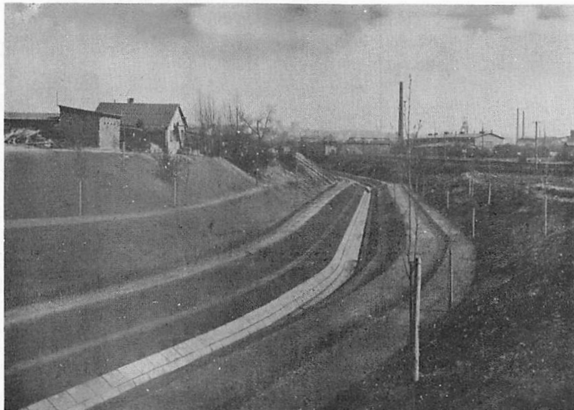
Bild 14: Wie Tafel 18 nach Wiederherstellung des Kanals (1950). Das offene Bachbett mit Betonplatten ausgelegt. Typischer trapezförmiger, gestufter Querschnitt. Gestaltung des Ufergeländes durch Rasen-, Strauch- und Baumbepflanzung. Im Hintergrund Lokomotivschuppen des Bahnhofes Essen-Nord, ein Förderturm der Zeche Elisabeth und der Wasserturm von Frillendorf.
