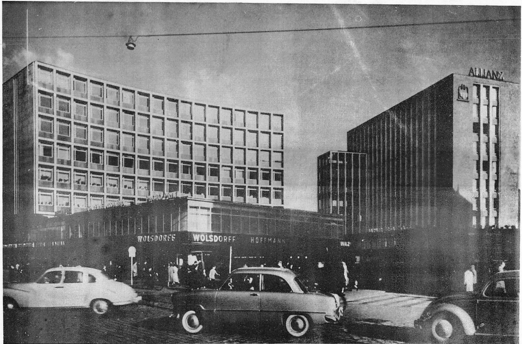
Bild 15: Kettwiger-Tor-Haus und Allianz-Haus von Süden gesehen. Beispiel der Verbindung von Geschäfts- und Bürohaus und der neugeschaffenen städtebaulichen Raumwirkung in der Geschäftsstadt (1955).
