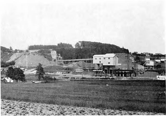
Bild 3: Neues Basaltwerk Stockum. Der im „Stöffel“ gewonnene Basalt wird auf einem langen Förderband zur Verarbeitung ins Werk transportiert
