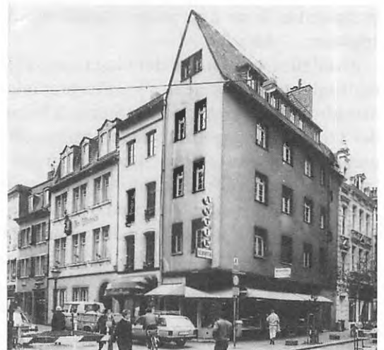
Abb. 4: Haus Bonngasse 14, Ecke Friedrichstraße a) Korrekturskizze der Bauaufsicht 1938 (Bauak- ten Bauaufsichtsamt Bonn) b) heutiger Zustand des 1938 erbauten Hauses, das 1947 als denkmalwert bezeichnet wurde (Foto: Lück 1986)
