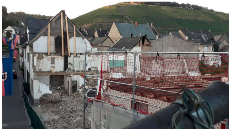
Abb. 70: Abrissarbeiten auf dem Areal „Winnigen-Mitte“ von Süden aus gesehen (IG Winniger Mitte, 01.09.2018)
