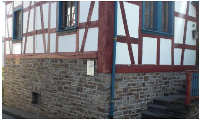
Abb. 18: Fachwerkhaus auf Bruchsteinsockel in Brey (eigene Aufnahme)
