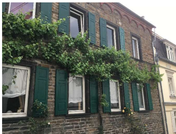
Abb. 19: Bruchsteinhaus in Winnigen (eigene Aufnahme)
