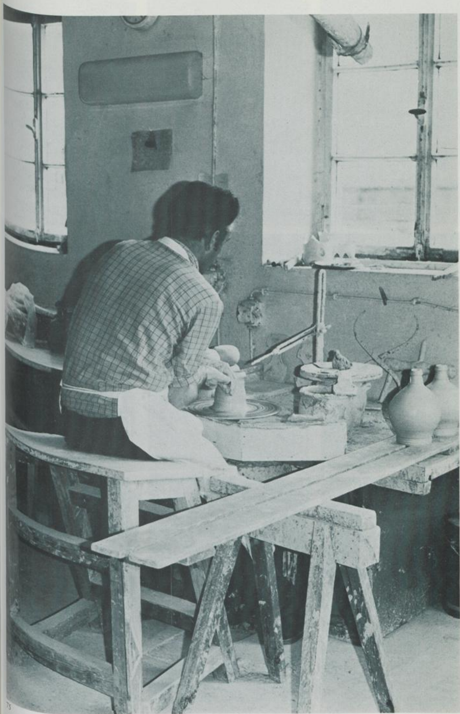
Abb. 75 Elektrische Drehscheibe mit Sitzvorrichtung in Speicher, 1975
