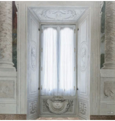
Abb. 329: Fensterrahmung unter dem Urteil Salomos
