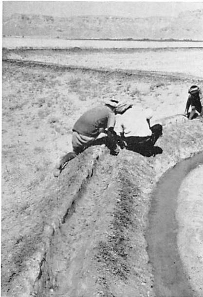
16. Bau eines neuen Kanals zur Pumpenbewässerung bei al-Qaṭn. (Sämtliche Aufnahmen vom Verfasser)
