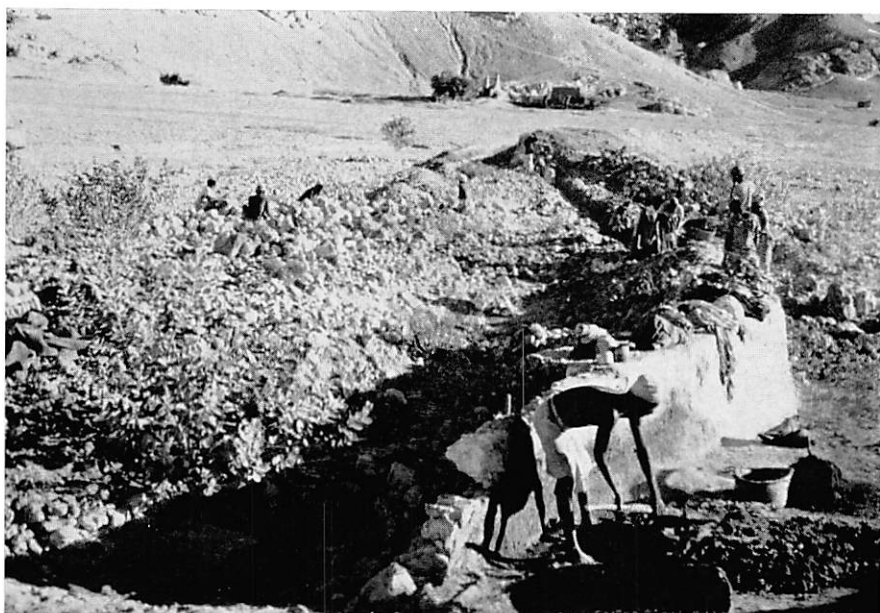
13. Dammbau zur Seylbewässerung in Saiwūn.
