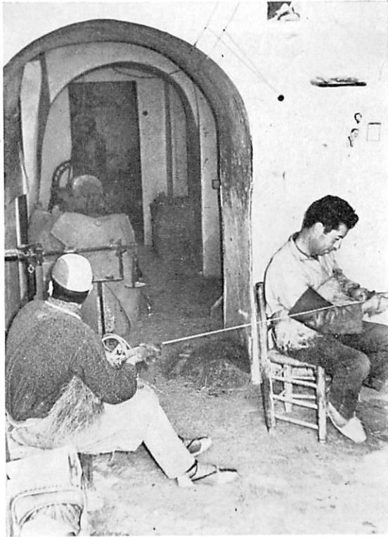
Bild 26: Teilmechanisierte Seilerei in einer Höhle von Crevillente. In den Höhlen von Crevillente werden die Faser des Espartograses und des Hanfes mit kleinen Motoren zu Fäden gesponnen und zu Schnur gedreht.
