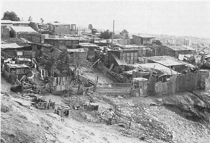
Bild 17: Callampas am Steilabfall der Küstenkordillere in Antofagasta (südl. des Friedhofs zwischen Bahn und Umgehungsstraße, vgl. Abb. 6 u. 79)
