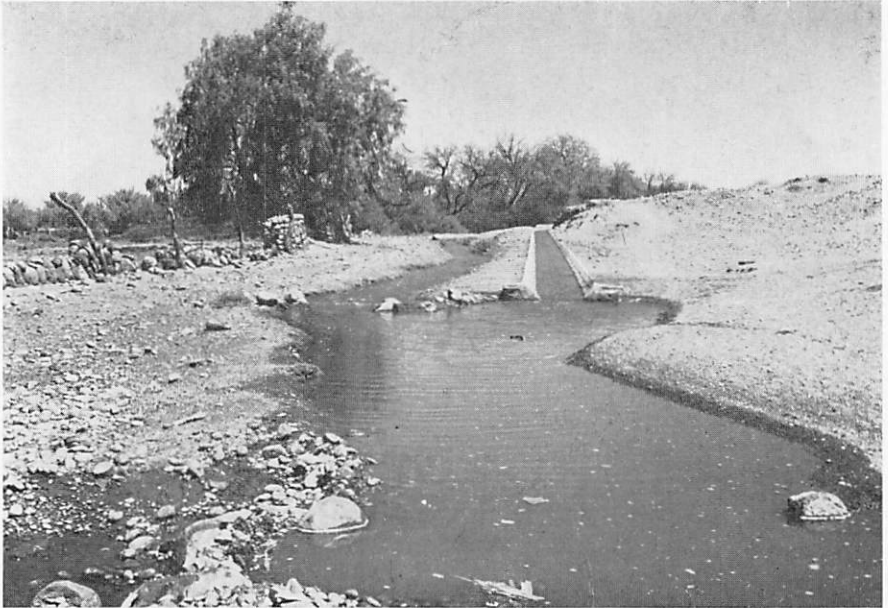
Bild 1: Bewässerungskanäle in der Oase San Pedro de Atacama (Erdkanäle überwiegen, nur wenige Hauptzuleitungen sind in Zement gefaßt)
