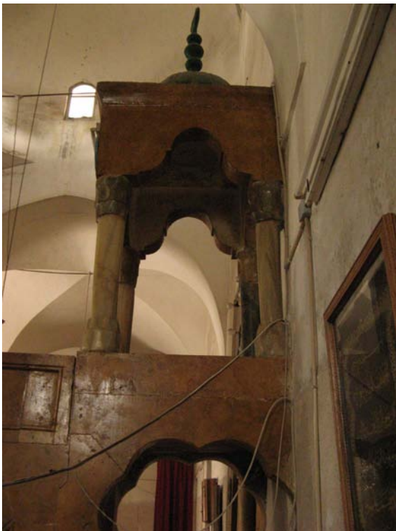
Minbar - Detail: Rechte Flanke des Baldachins
