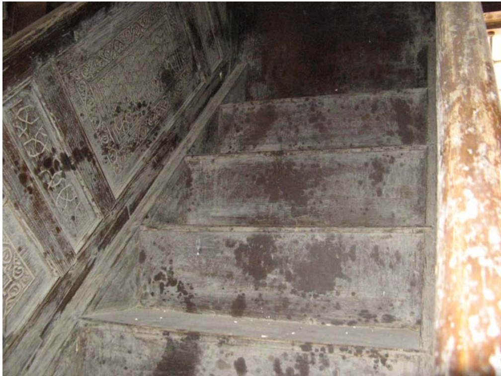
Minbar - Detail: Treppe
