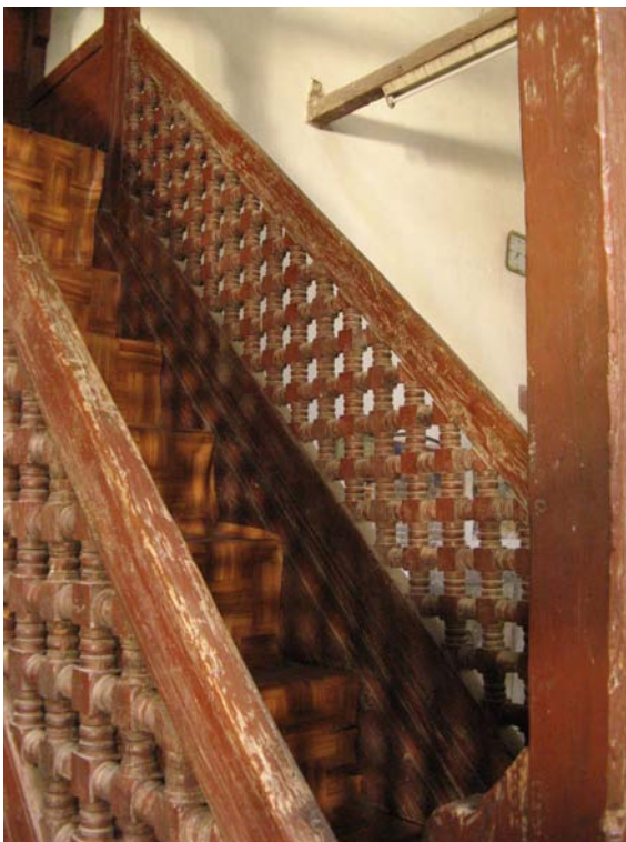
Minbar - Detail: Treppe
