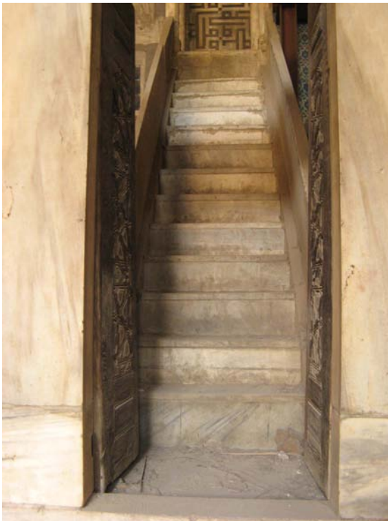
Minbar - Detail: Treppe
