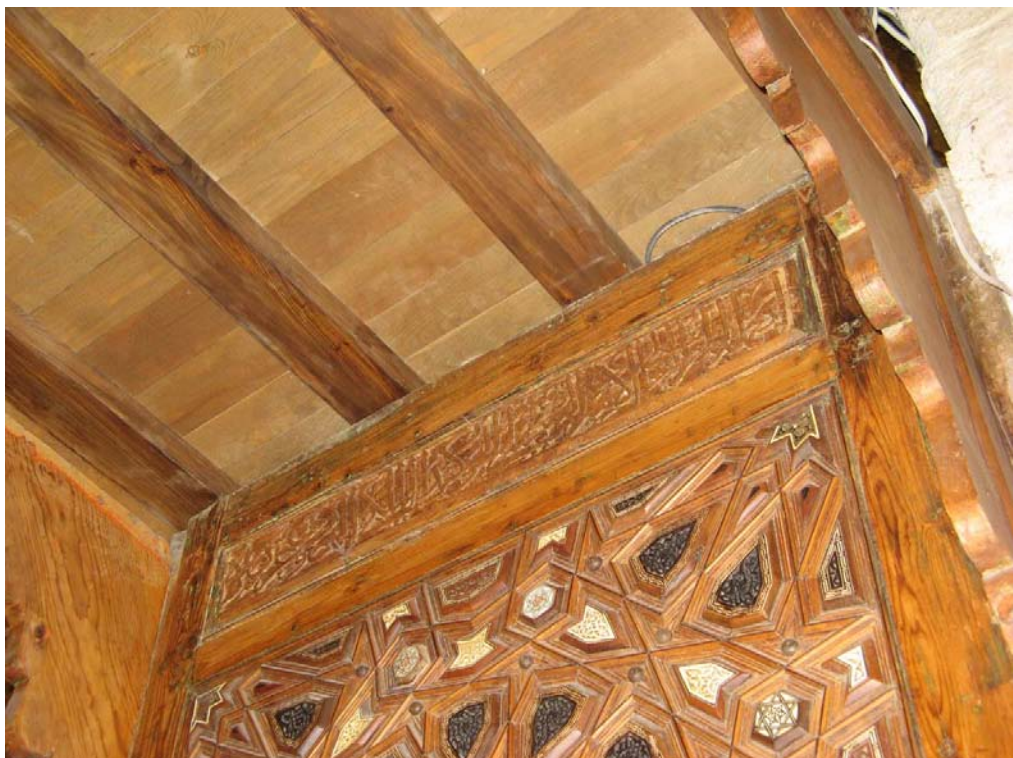
Minbar - Detail: Linke Flanke, Durchgang, Inschrift
