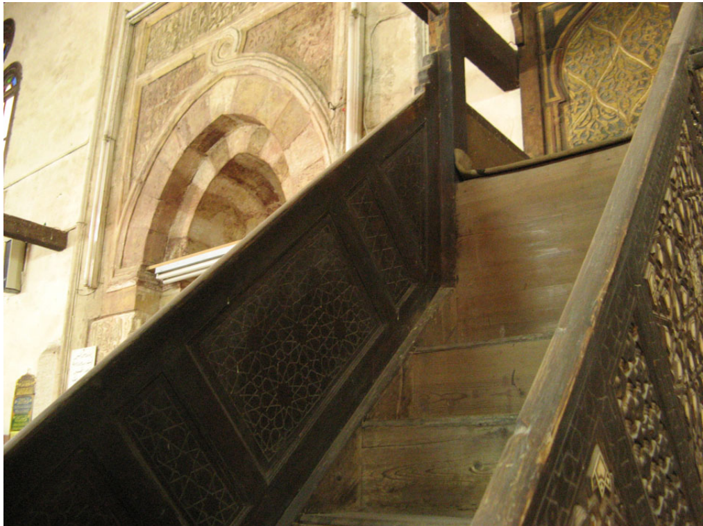
Minbar - Detail: Treppe
