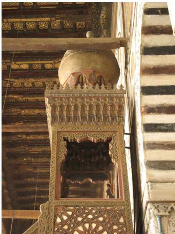
Minbar - Detail: Rechte Flanke des Baldachins
