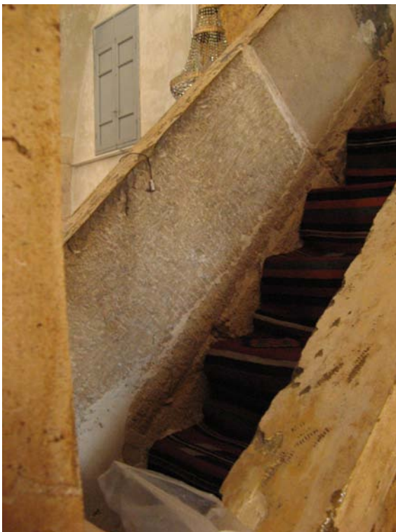
Minbar - Detail: Treppe
