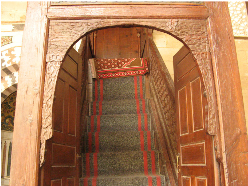
Minbar - Detail: Treppe
