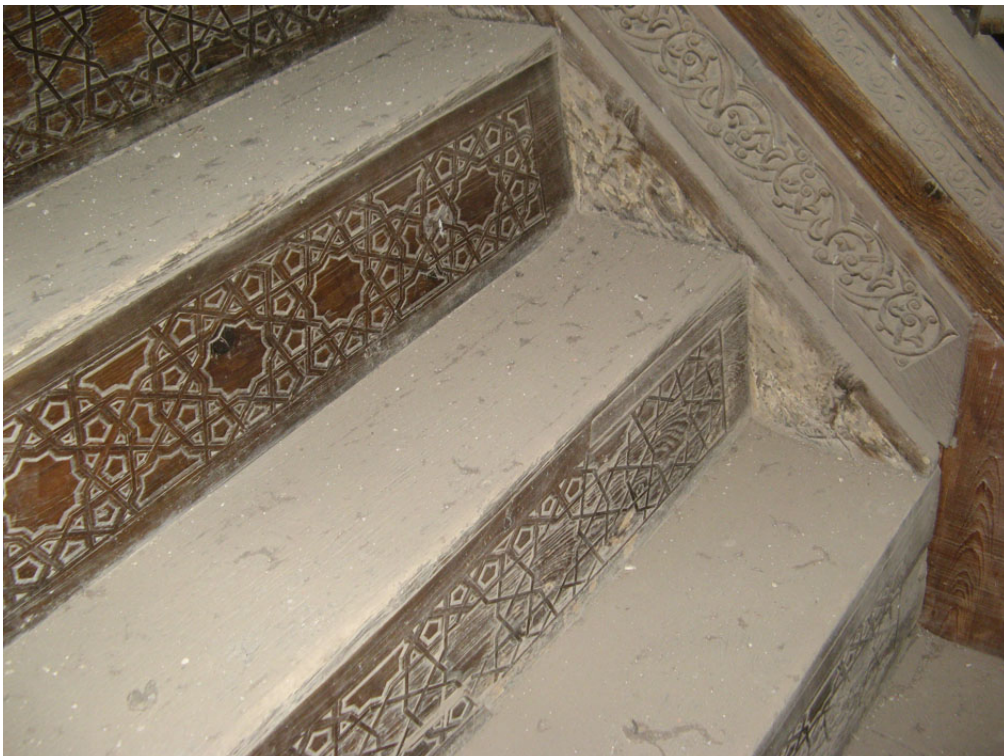
Minbar - Detail: Treppe
