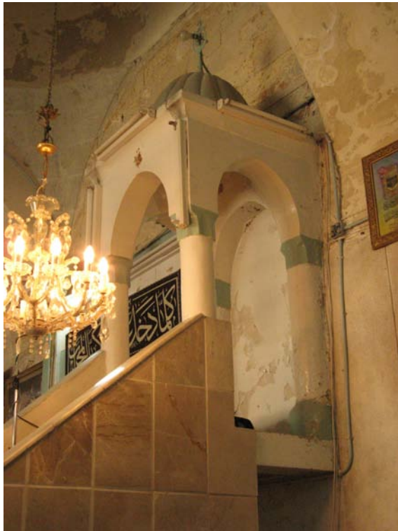
Minbar - Detail: Rechte Flanke des Baldachins
