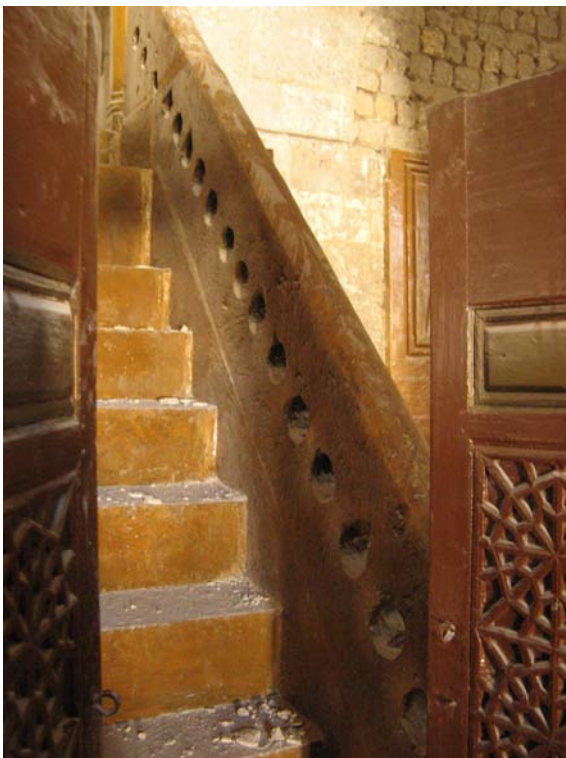
Minbar - Detail: Treppe
