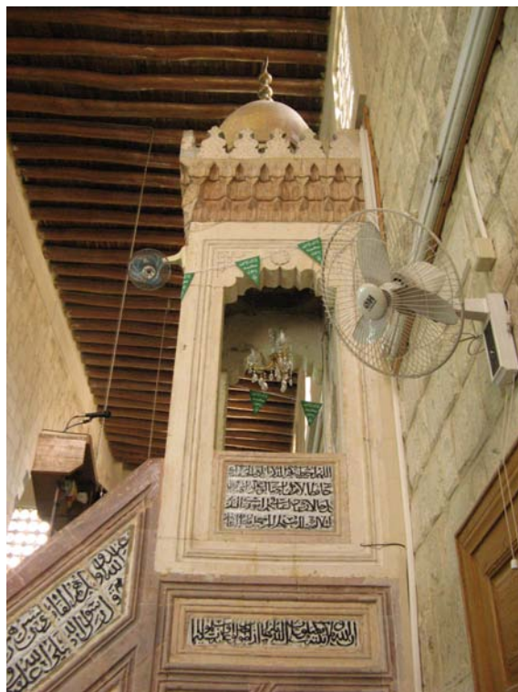
Minbar - Detail: Rechte Flanke des Baldachins
